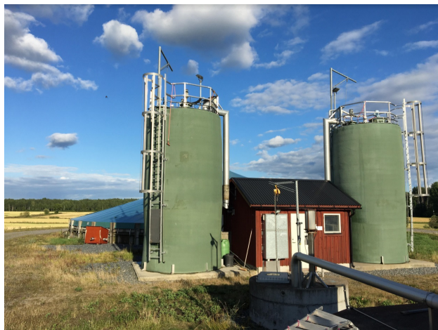
Figur 8: Anläggningen för våtkomposteringen.
