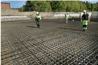
ARMERINGSJÄRN Till bottenplattan behövs 90 ton armeringsjärn. Det berättar Kjell Mattsson som står längst till vänster. Till höger om honom står Gottfrid Öhberg och Patrik Jörgenson.
