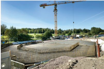
GIJTNING På onsdag gjuts den halvan av bottenplattan som är närmast i bild. Till gjutningen krävs 35 fullastade betongbilar.
