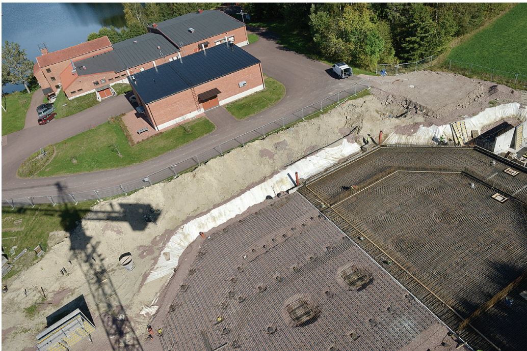
BOTTENPLATTA Från lyftkranens topp får man en överblick över vattenreservoaren. Den högra halvan av bottenplattan är färdigt armerad och ska gjutas med betong på onsdag. Foto: Stefan Öhberg
