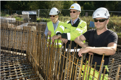
RUNDTUR Nyan fick en rundtur på bygget. Kjell Mattsson, Gottfrid Öhberg och Patrik Jörgenson visar upp de grova armeringsjärnen som används till vattenreservoarens bottenplatta.
