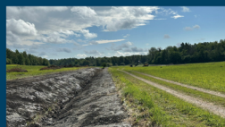
Avfasade dikekanter för att minska erosionen och därmed näringstillförseln till dricksvattentäkten. Foto: Ålands Vatten
