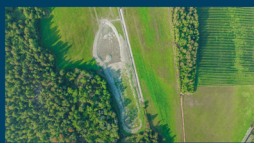
Multifunktionell våtmark intill Prästgårdsnäsets naturreservat. Förutom att fånga upp näringsämnen ska den övre bassängen fungera som dricksplats för betesdjuren. Bilden är tagen en vecka efter att grävarbetena avslutades. Foto: Flygfoto Åland
